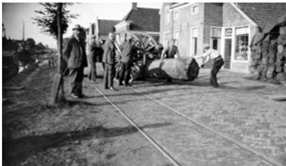
Medewerkers van timmerfabriek Bos te Nieuwe Pekela verslepen met een mallejan een dikke eikenstam
